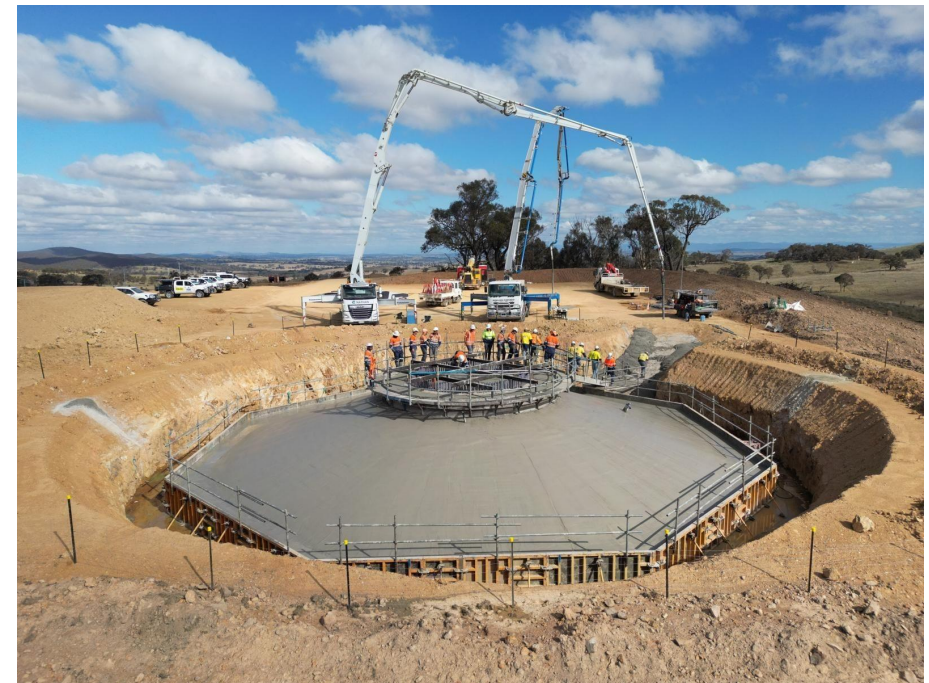
Figure 1: Final foundation pour
