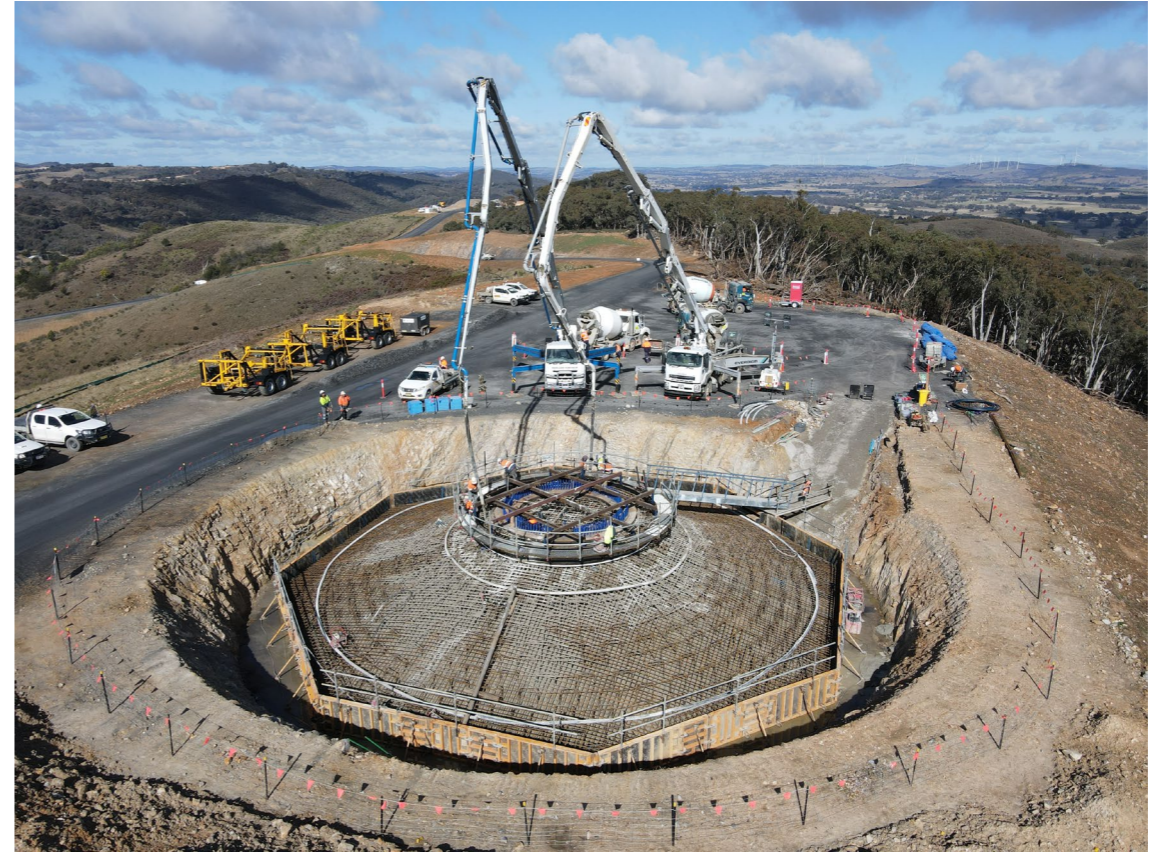
WTG foundation pour
