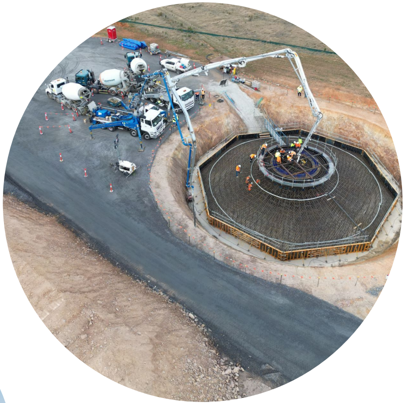
Figure 3: Foundation pour
